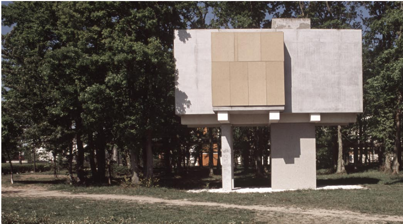
vue d'ensemble de l'intervention
