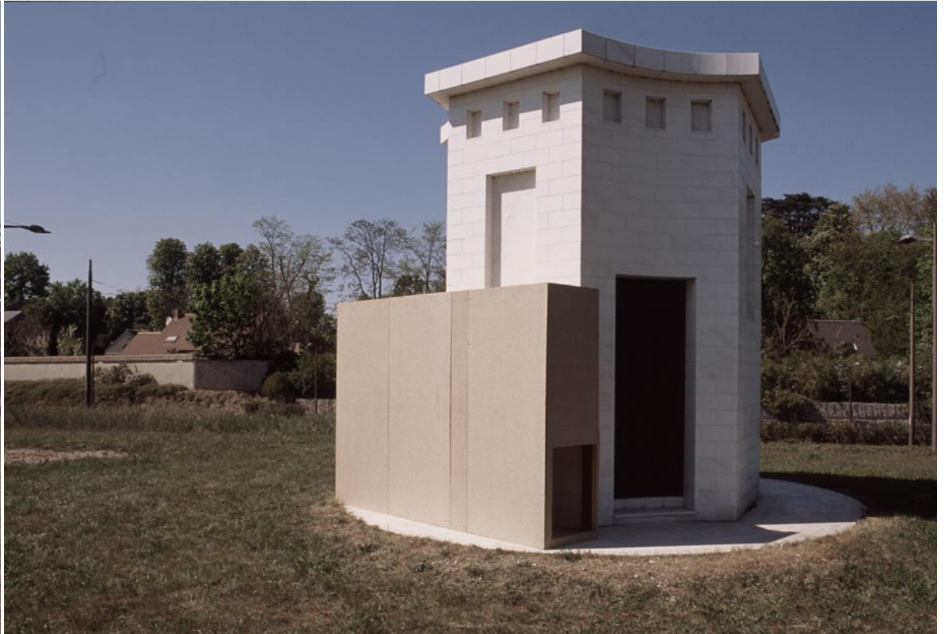
vue d'ensemble de l'intervention
