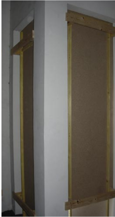
vue intérieure (détail)
