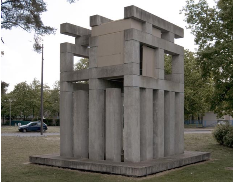
vue d'ensemble de l'intervention
